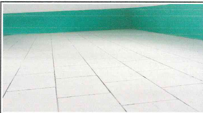
Foto 2: Finalización de piso cerámico en sustitución de torta de cemento del Área de cocina.
