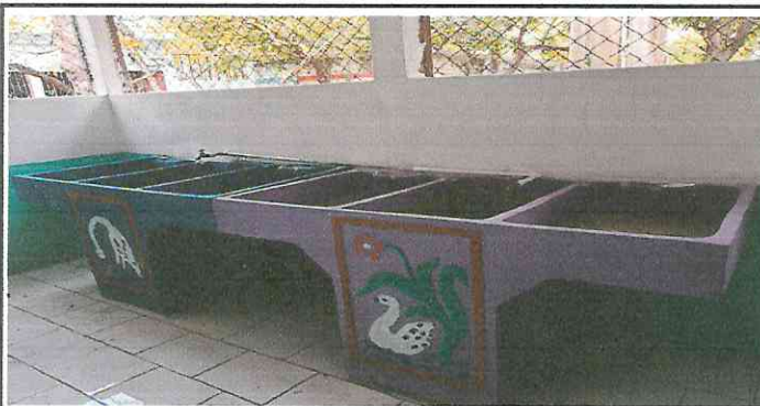
Foto 5: Finalización de dos pilas en área de cocina
