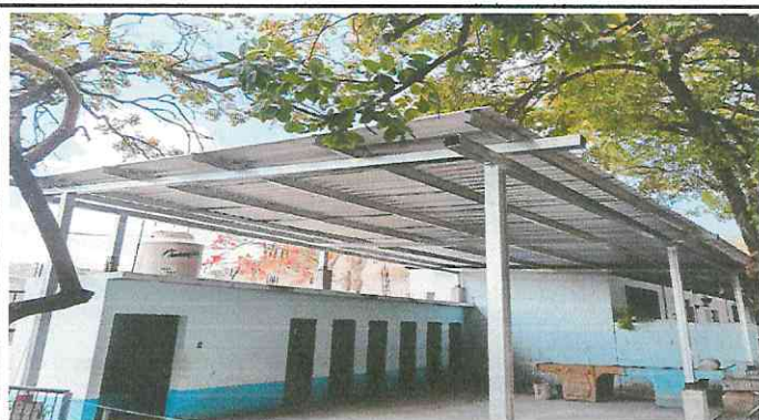
Foto 3: Finalización de sustitución de galera de lámina y madera por estructura metálica
