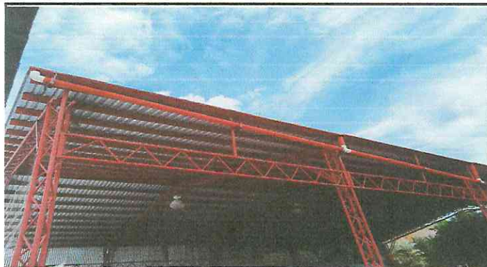
Foto1: Finalización de la Sustitución de caída de agua Pluvial con salida a la calle que estaba quebrada por el paso del tiempo.
